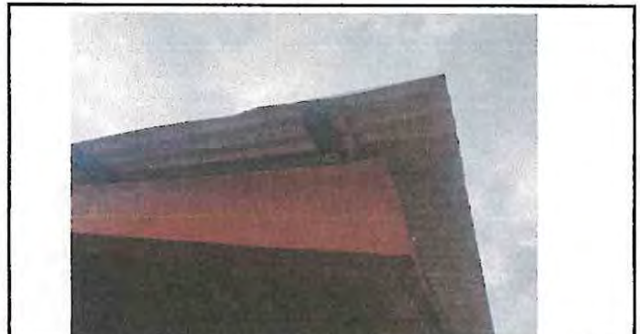
Foto 4: Sustitución de lámina acanalada por lámina troquelada calibre 26, aulas, corredor, cocina y baños
