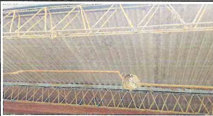
Foto 1: Sustitución de estructura metálica con oxidación, por estructura metálica galvanizada, aulas, corredor, cocina y baños
