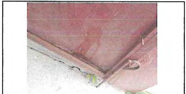
Foto 6: Sustitución de puerta aula 2
