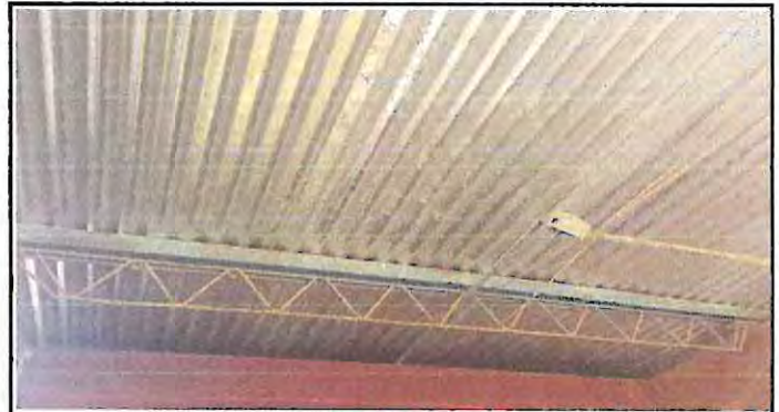
Foto 2: Sustitución de estructura metálica con oxidación, por estructura metálica galvanizada, aulas, corredor, cocina y baños
