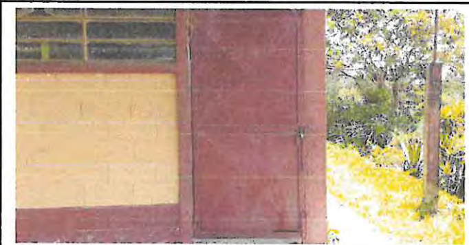
Foto 5: Sustitución de puerta aula 1
