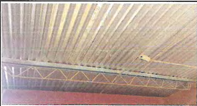
Foto 3: Sustitución de lámina acanalada por lámina troquelada calibre 26, aulas, corredor, cocina y baños
